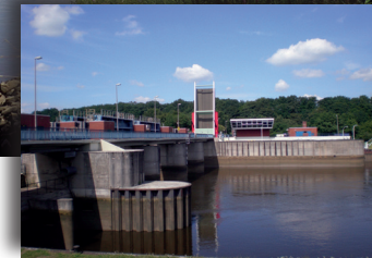
Das Lesumer Sperrwerk mit hochgezogener Klapp-Brücke
